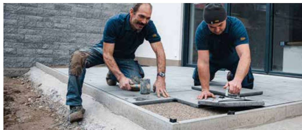
INFO Abb. = Verlegung im Splittbett
