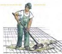
5. **Fläche sauber abkehren und mit einer geeigneten Rüttelplatte mehrmals längs- und quer abrütteln.** Immer an einer Außenseite der Fläche und am tiefsten Punkt beginnen. Zum Schutz der Steinoberfläche vor Kratzspuren und Kantenabplatzungen einen Rüttler mit Kunststoff- oder Gummipolster verwenden. Nachmals mit Fugensand ein- und anschließend abkehren. **Die gepflasterte Fläche ist nach dem Rütteln sofort benutz- und befahrbar.**
